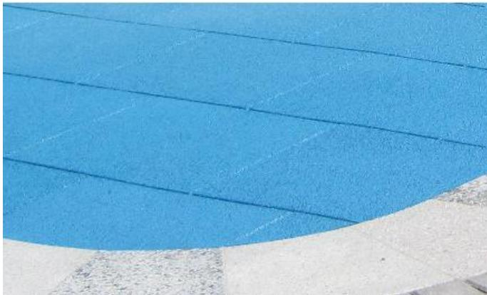
Die Platten der ersten und letzten Reihe sowie alle Rand- bzw. Eckplatten sind untereinander sowie mit der Flächenbegrenzung bzw. Kanteneinfassung zu verkleben, um die Platten gegen unbefugtes Entfernen zu sichern.
